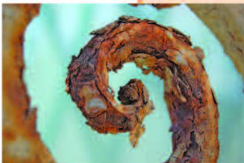
Figura 4.25 El herrumbre se produce por una reacción redox.
