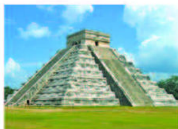
5.25 El Templo de Kukulcán, en Chichén Itzá, fue construido con base en una técnica llamada estereotomía, la cual se fundamenta en usar figuras geométricas tridimensionales regulares. ¿Qué tipo de piedra se usaba en la construcción para tallarla en formas perfectas?
